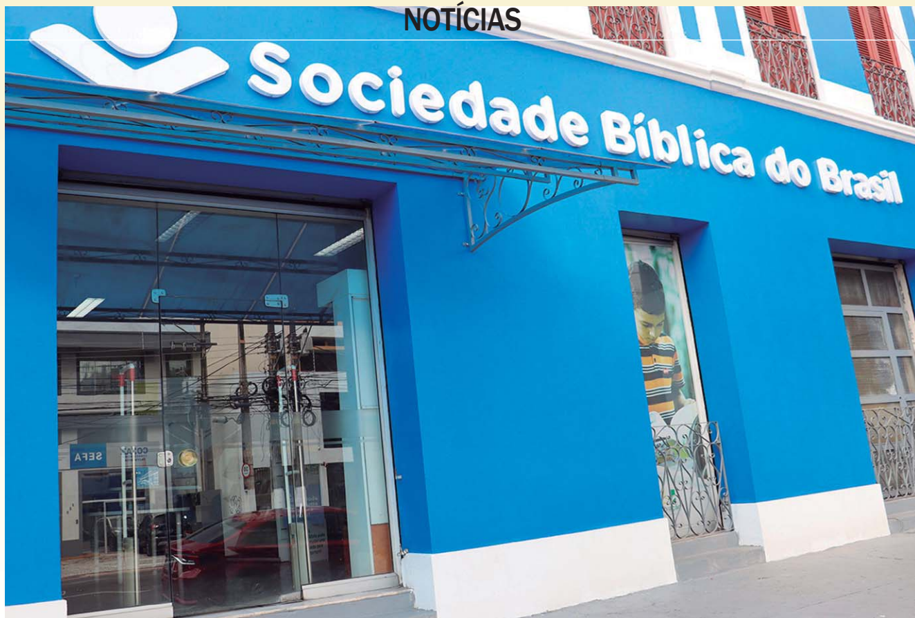
FACHADA da sede da Sociedade Bíblica do Brasil, em Belém, PA, um dos futuros Centros Culturais da Bíblia
